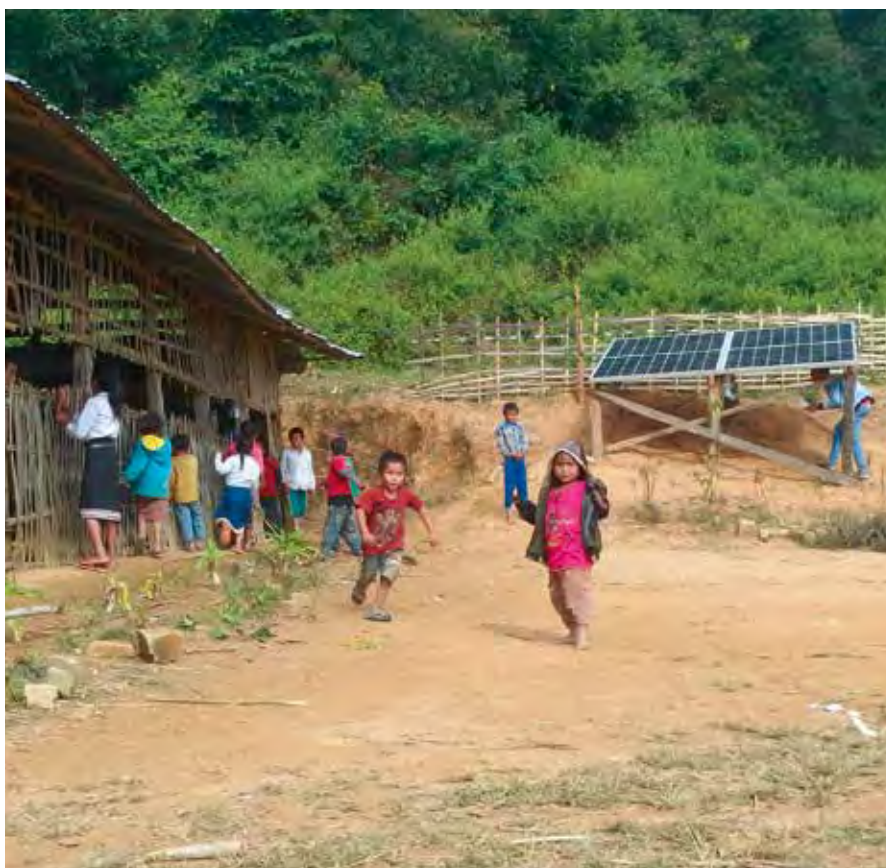
Installation de panneaux photovoltaïques dans un village, Laos
