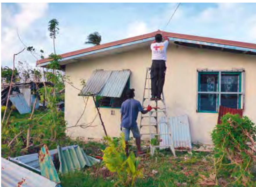
Sécurisation des installations électriques suite au passage du cyclone Pam, Vanuatu
