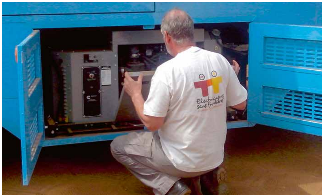
Réalisation de l'alimentation électrique continue d'un bus de soins, Guinée Conakry
