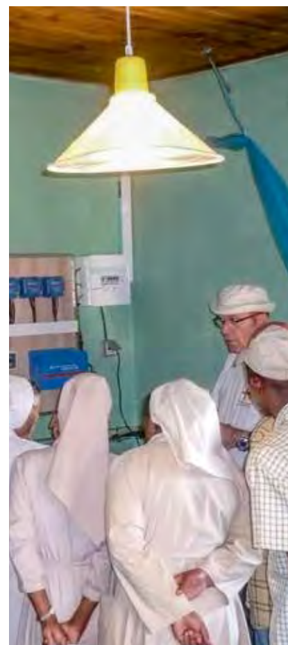
Formation à la maintenance des installations électriques, Madagascar
