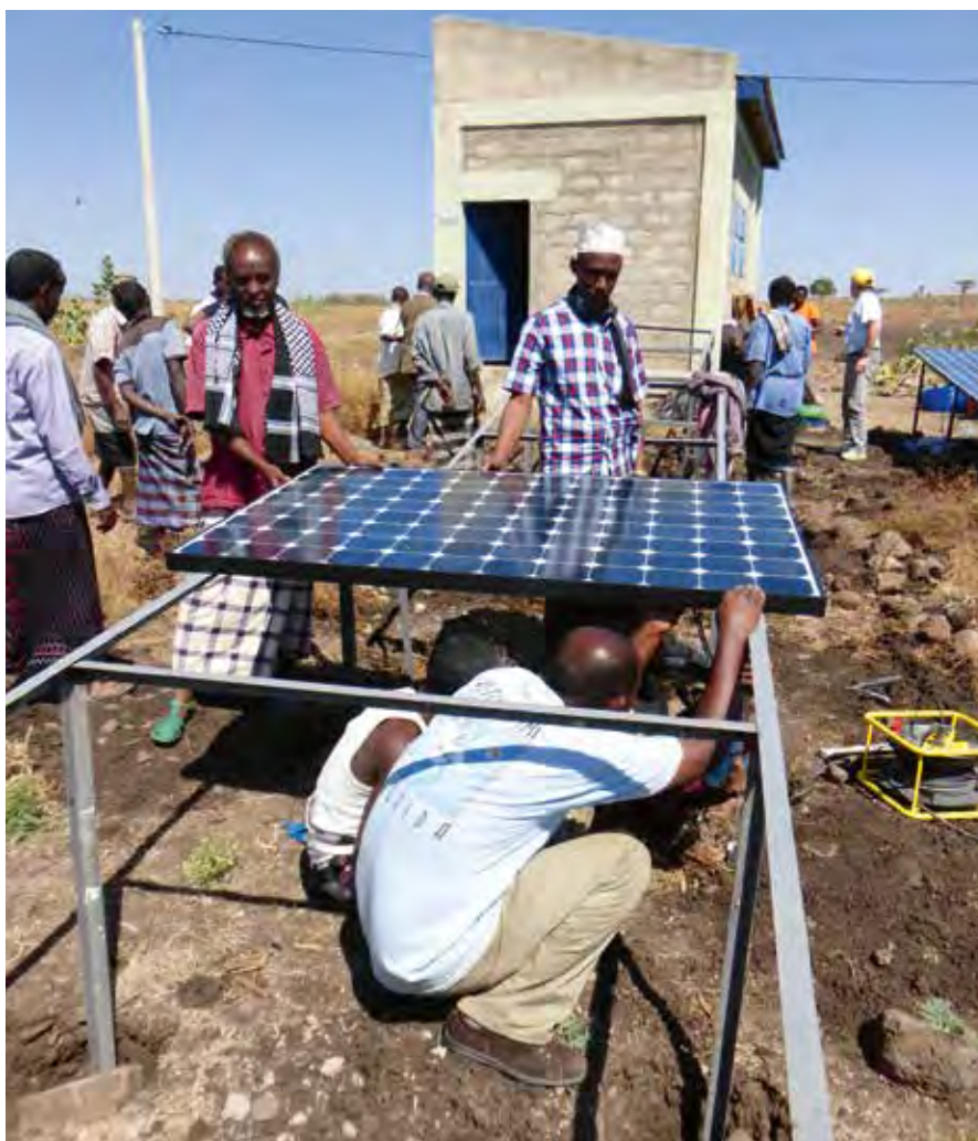
Installation de panneaux solaires par la population locale suite à une formation, Éthiopie
