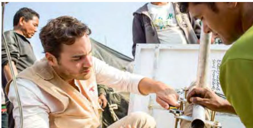
Installation d'un panneau solaire lors d'une missions d'urgence, Népal
