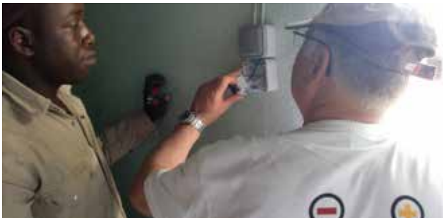
Vérification des installations, Gomponsom, Mali.
