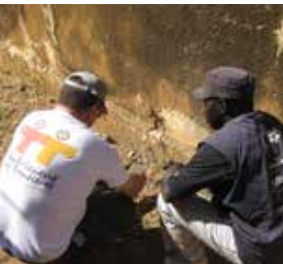
Vérification électrique, Saponé, Burkina Faso.
