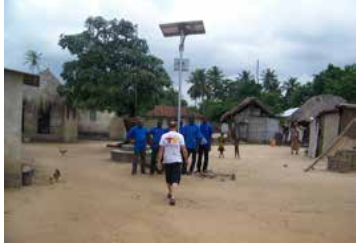
Vérification des panneaux photovoltaïques, Yobo, Togo.
