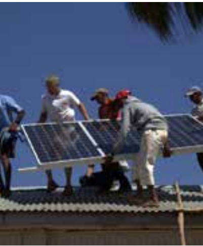
Installation de panneaux solaires, Ankarazobe, Madagascar.
