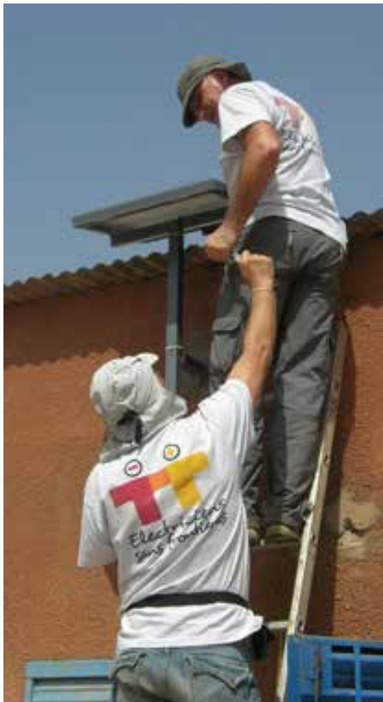
Montage de panneaux solaires, Burkina Faso.
