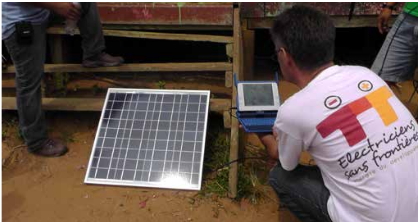
Test des panneaux solaires, Puerto Maldonado, Pérou.
