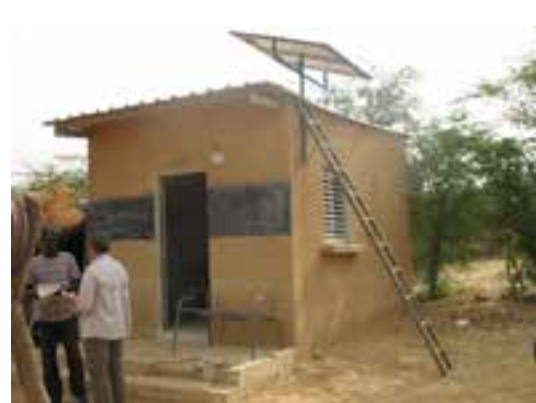
Évaluation des installations, Mboyo, Sénégal.
