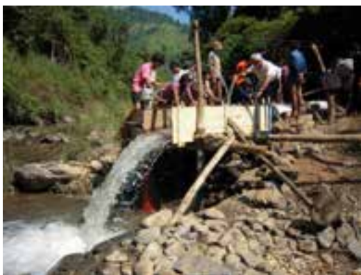
Installation d'une pico turbine, Phongsaly, Laos.
