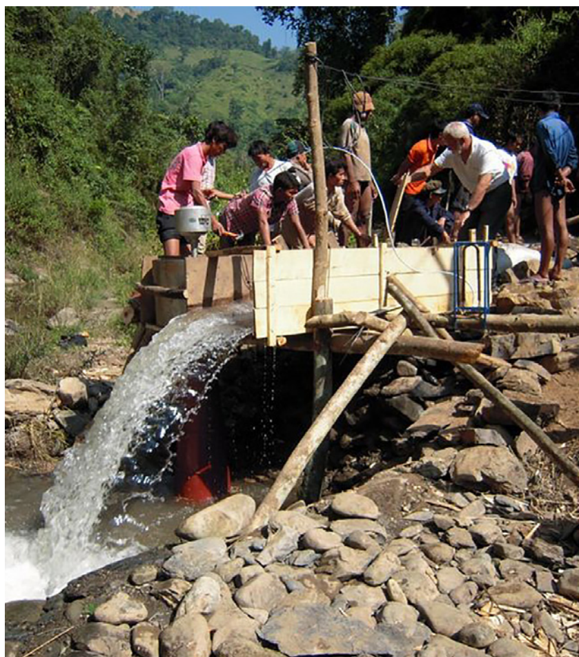
installation d'une pico turbine au village de Phongsaly, Laos
