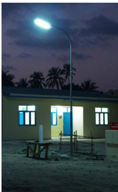
Projet d'éclairage public sur l'île de Gan, Maldives
